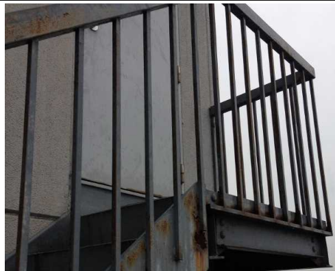
㉓ 鉄骨階段屋根上、防水のひび割れ、劣化
