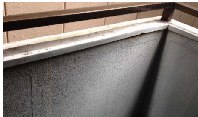
⑯ 共用部廊下窓枠の劣化(雨漏り)
