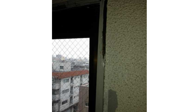
⑯ 共用部廊下窓枠の劣化(雨漏り)
