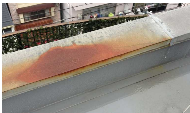
⑪ バルコニー手摺壁の笠木の割れ、欠損
