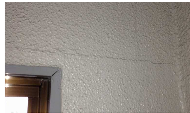
⑮ 共用部廊下、外壁面の割れ
