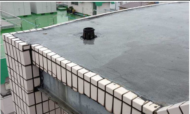
㉓ 鉄骨階段屋根上、防水のひび割れ、劣化
