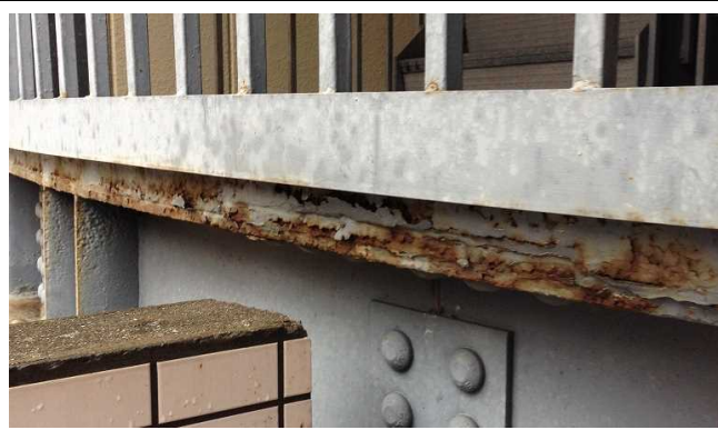
㉒ 鉄骨階段の梁、鉄骨の腐食
