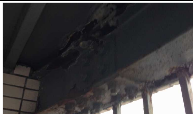
⑳ 鉄骨階段手摺の錆
