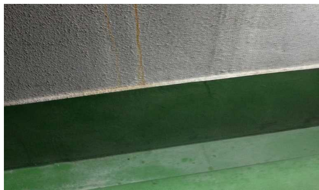
⑮ 共用部廊下、外壁面の割れ
