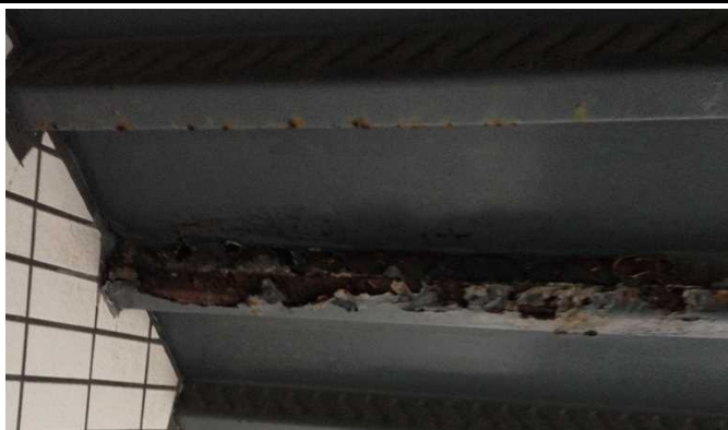
⑲ 共用部鉄骨階段手摺の腐食
