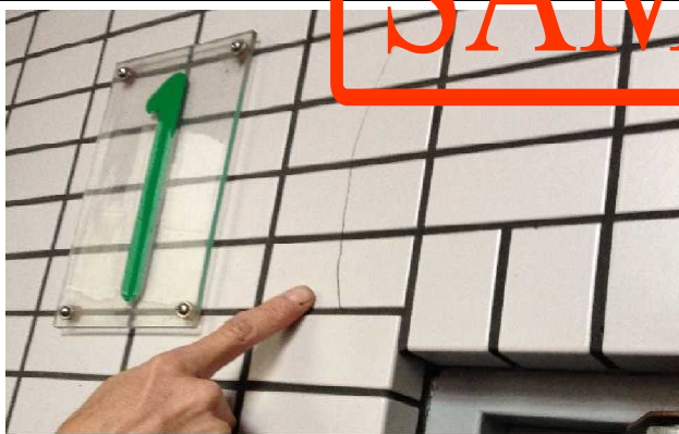
⑤ 鉄骨階段屋根部分のタイルの欠損
