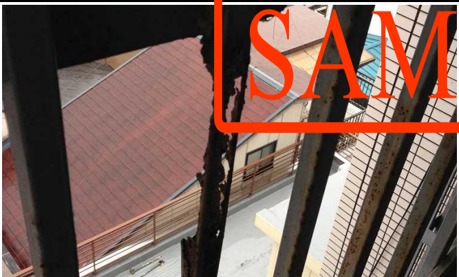
㉑ 屋上鉄骨階段の錆
