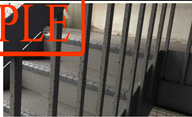
㉒ 鉄骨階段の梁、鉄骨の腐食
